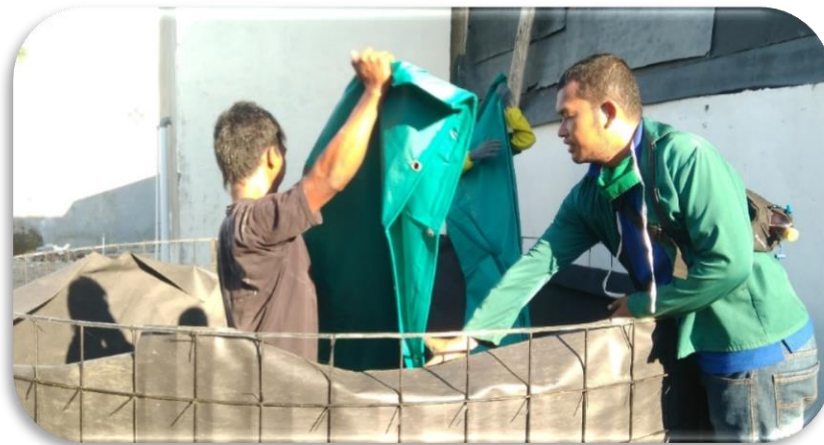
Gambar 2. Proses pemasangan Terpal
