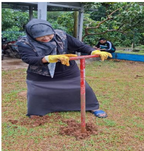
Gambar 3. Demonstrasi Teknik Pengeboran Lubang Resapan Biopori (LRB) oleh Tim Pengabdian
